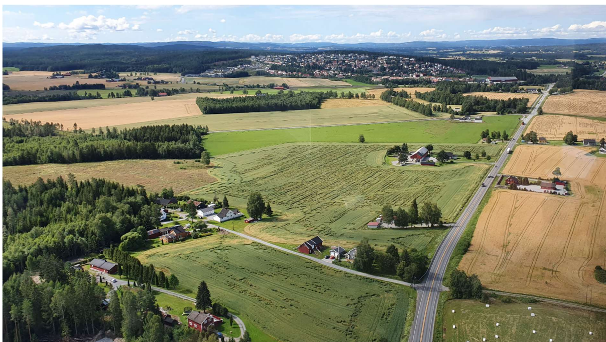
Figur 5-12 Kongsvingervegen, eksisterende E16, i Nes kommune, sett mot vest. Neskollen, nær kommunegrensen mellom Nes og Ullensaker, kan ses i øvre del av bildet (Kilde: Helikopterbefaring aug. 2020).
